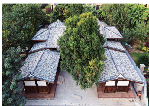
侯德榜故居修缮主体完工。
