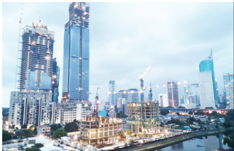
雅加达市中心一个建筑工地。(林永传 摄)
