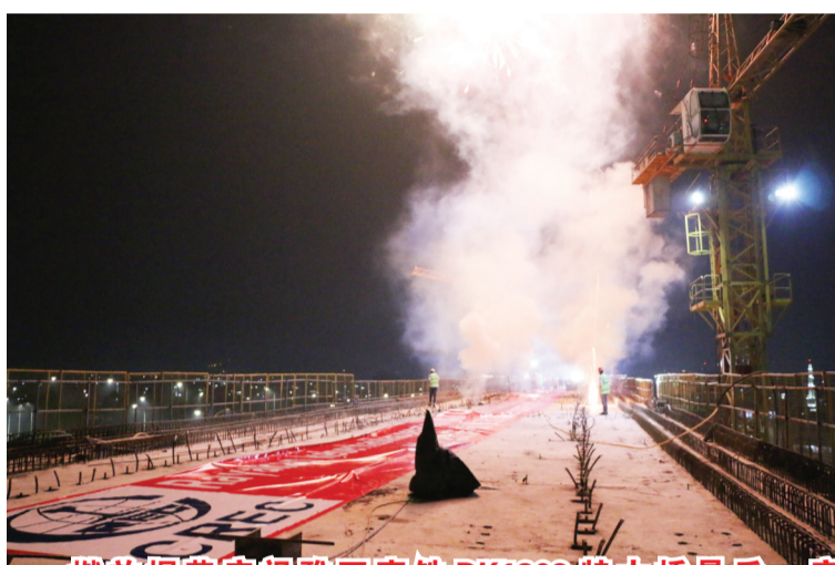
燃放烟花庆祝雅万高铁DK1203特大桥最后一座主跨100米连续梁混凝土顺利浇筑
