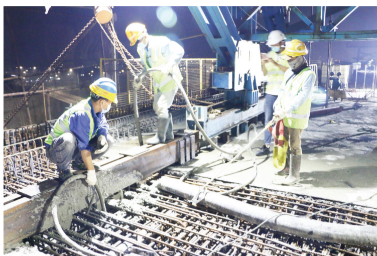
混凝土浇筑
