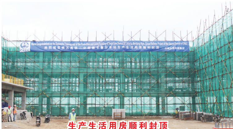
生产生活用房顺利封顶
