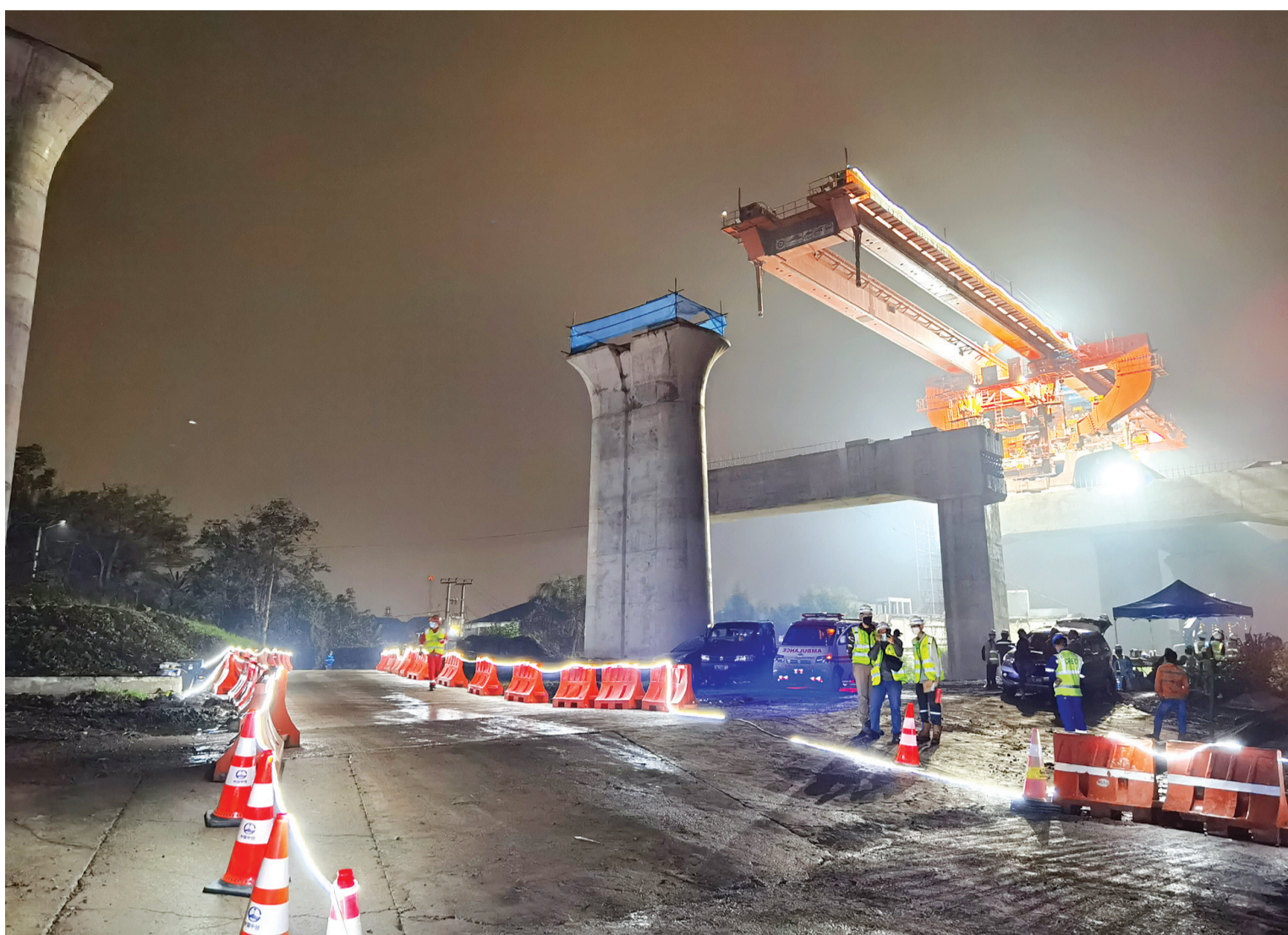
跨路架梁现场
