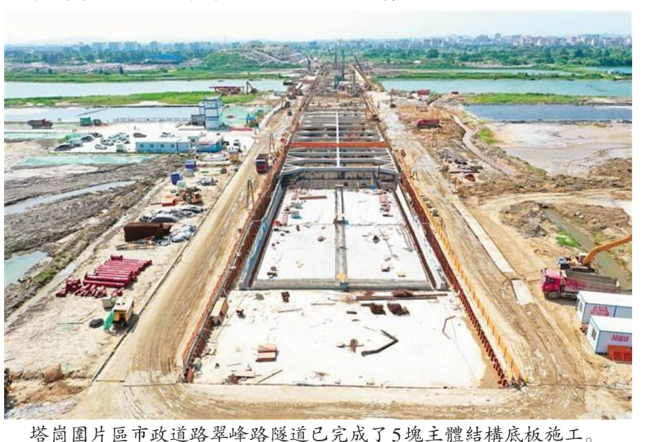
塔崗園片區市政道路翠峰路隧道已完成了5塊主體結構底板施工。
