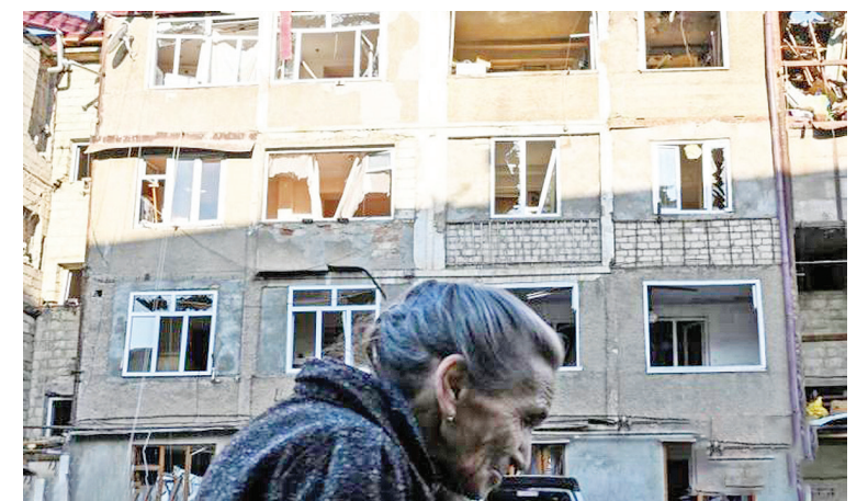
纳卡地区主要城市斯捷潘纳克特在交火中受到波及,居民住宅受损。图为受损的居民住宅。
