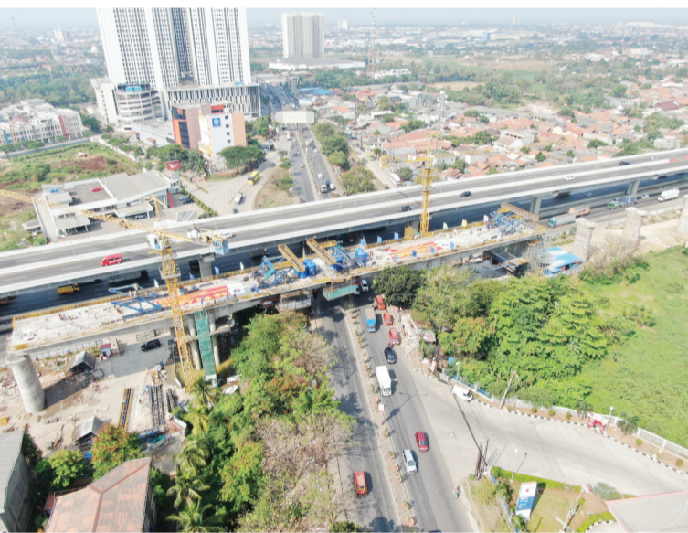
这是9月24日拍摄的雅万高铁2号特大桥一处64米跨刚构连续梁合龙现场(无人机拍摄)。
