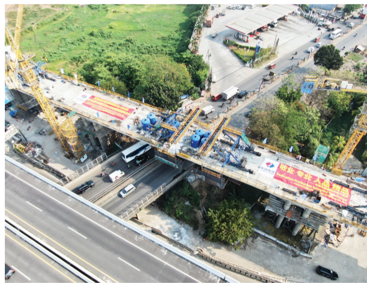
这是9月24日拍摄的雅万高铁2号特大桥一处64米跨刚构连续梁合龙现场(无人机拍摄)。
