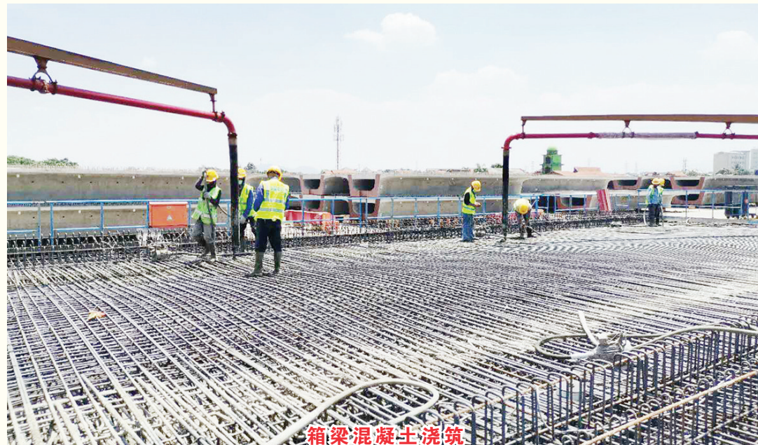
箱梁混凝土浇筑
