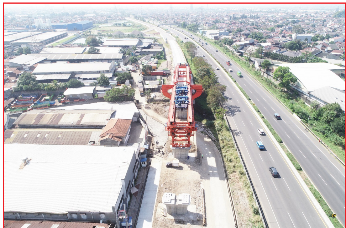
雅万高铁4号梁场全面启动万隆段箱梁架设施工
