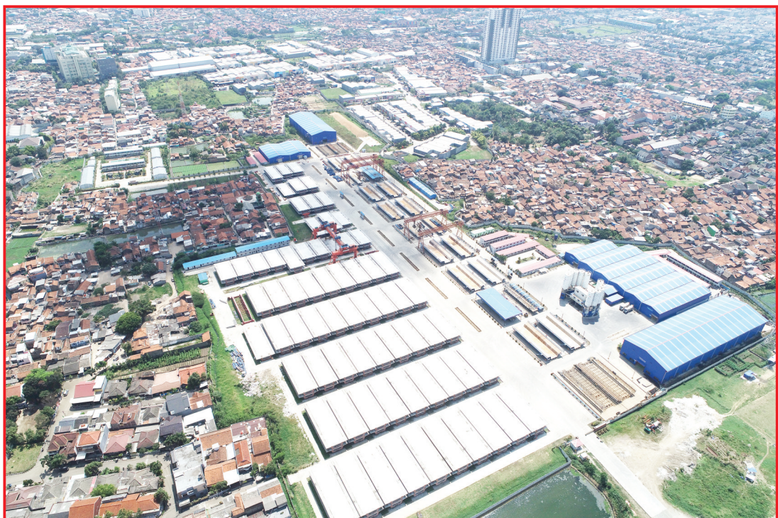
万隆制梁场生产区航拍
