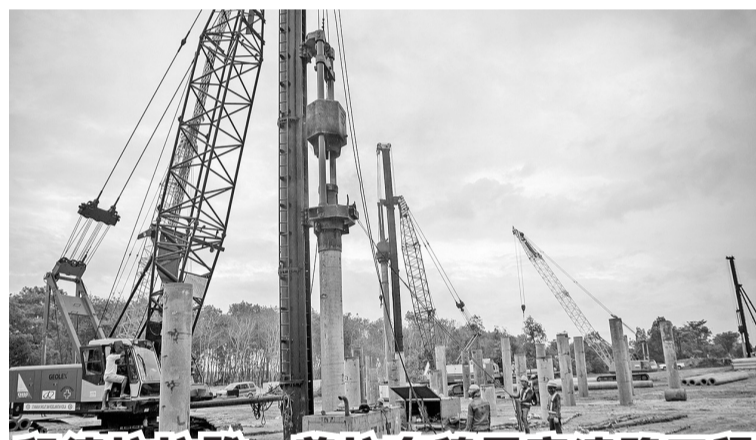
印德拉雅 - 普拉布穆里高速公路工程
