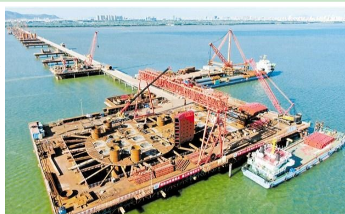
牛田洋快速通道牛田洋特大橋首個主墩圍堰開始拼裝。
