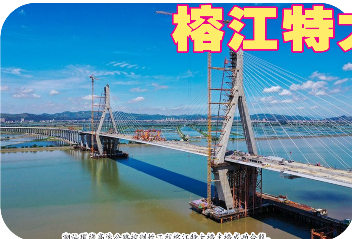
潮汕環綫高速公路控制性工程榕江特大橋成功合龍。
