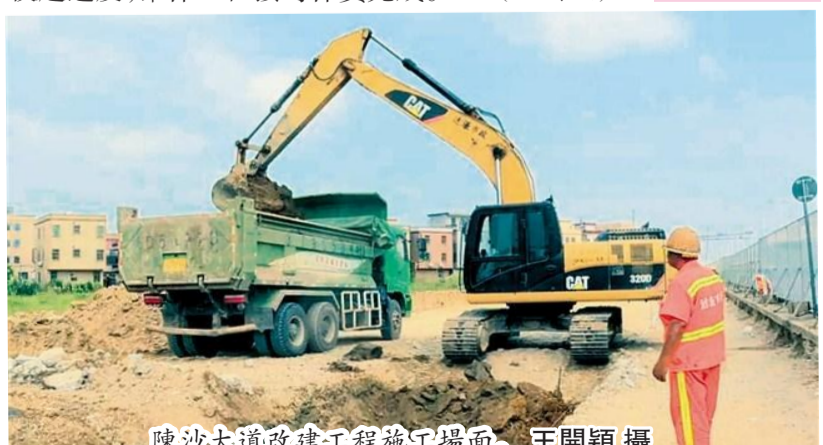
陳沙大道改建工程施工場面。王開穎攝
